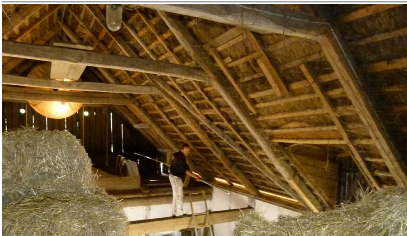
Tagrummet under vestre længes sydvestre halvdel.
