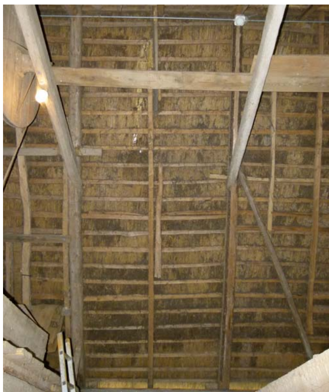
Underside af bredt spærfag. Der er opsat forstærkninger gennem tiden
